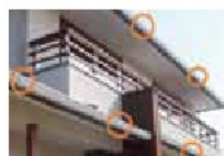
軒樋は既製品の場合3.6mと定尺品であるため継手箇所がよくわかる
