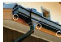
軒樋の支持金具が見える
